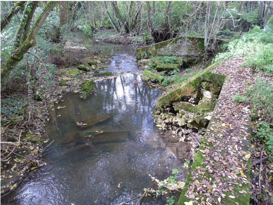
L'ouvrage à démolir
