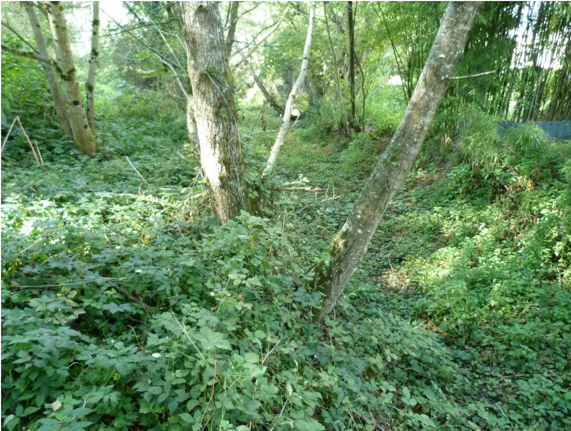
A droite Le bief envahi de végétaux et souches
